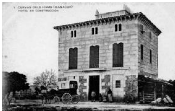
Figura 1: Postal de les primeres dècades del segle XX on s'observa l'hotel que es va construir en terrenys de Ca n'Olesa, quan es condicionaren les Coves dels Hams per a la seva visita turística. Les cavitats estudiades es troben a les rodalies d'aquest edifici, actualment reconvertit en un modern i més gran establiment hotelier.
